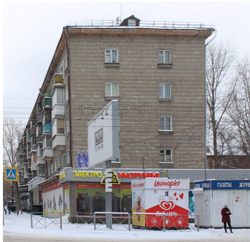
Фасад 1-3, выходящий на проспект Карла Маркса
